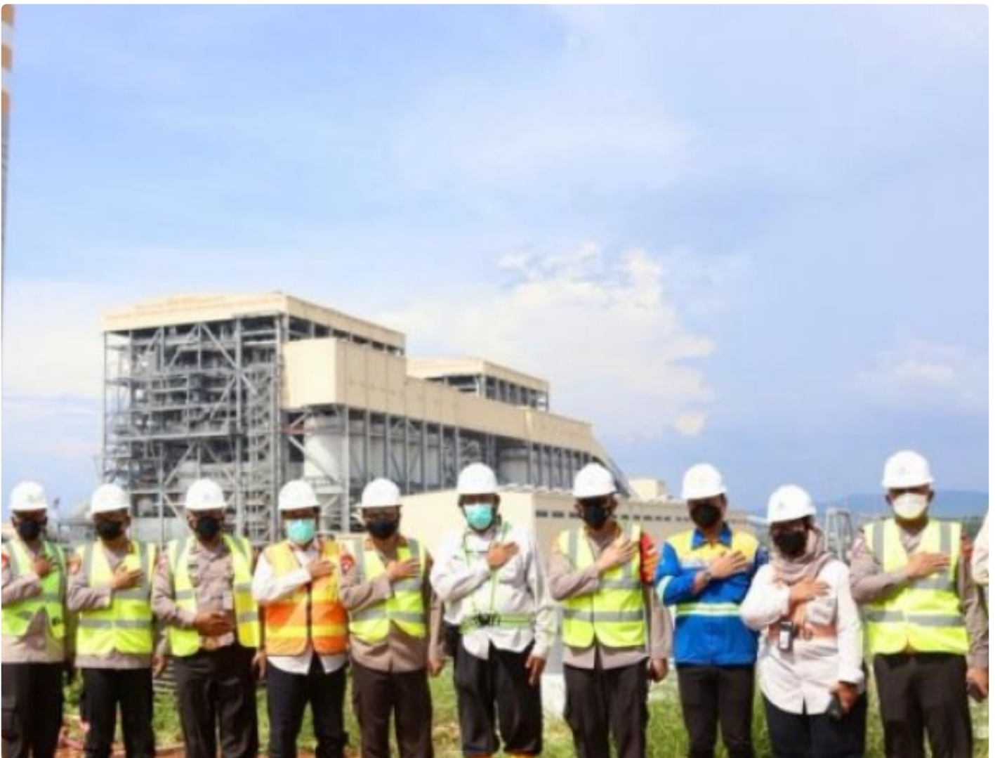
Proyek Strategis Nasional Pembangunan Kawasan Industri Batang serta Proyek PLTU Batang, ditinjau Kapolda Jateng, Irjen Pol Ahmad Luthfi, Kamis (19/5/2022).
